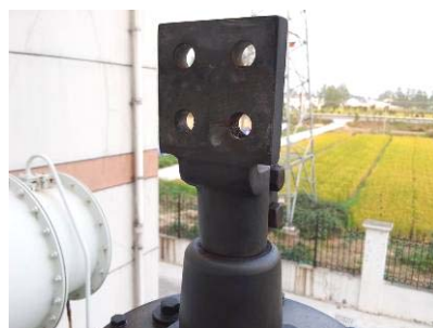
图 2 变压器线夹
