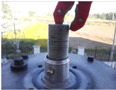
图 5 变压器导杆
