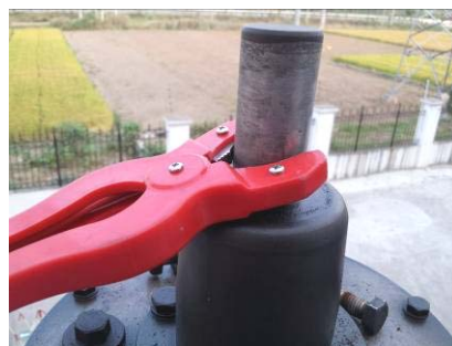
图 3 变压器将军帽
